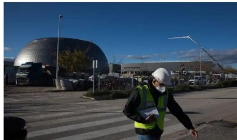
Vista de las obras de construcción del hospital de pandemias y emergencias Isabel Zenda en Valdebebas (Madrid). VÍCTOR SAINZ
